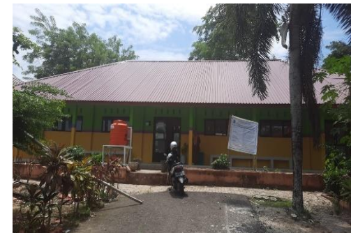
e. 3 ruang kelas yang sudah di renovasi
